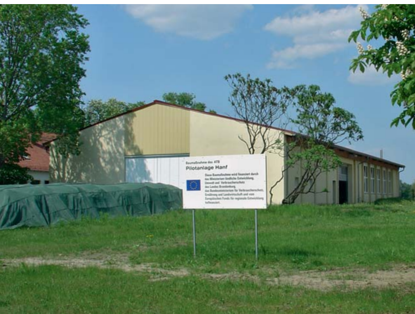
Die neue Pilotanlage Hanf. Vor der Halle lagert der Rohstoff in Silierschläuchen.
