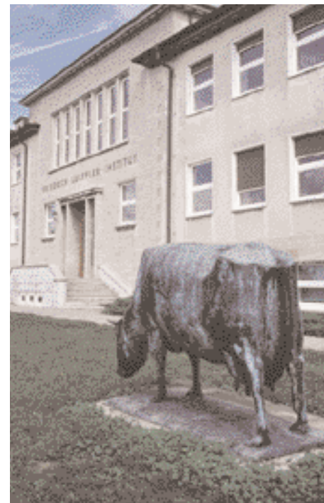
Hauptgebäude der BFAV auf der Insel Riems. Die Ostseeinsel ist Standort des neuen BSE-Instituts
