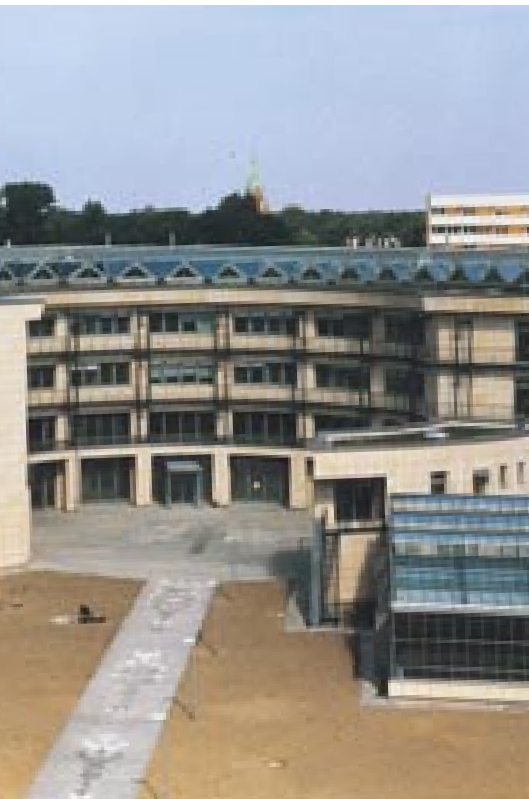
Das neue Gebäude der Bundesforschungsanstalt für Ernährung in Karlsruhe
