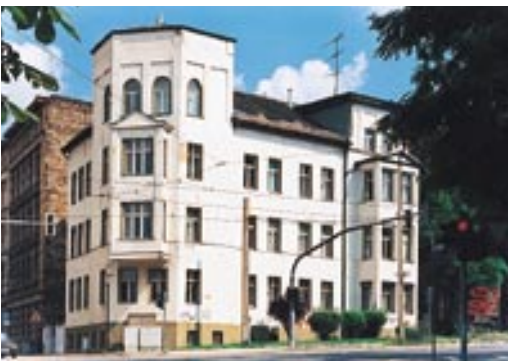
Das Dienstgebäude des IAMO in Halle/Saale
