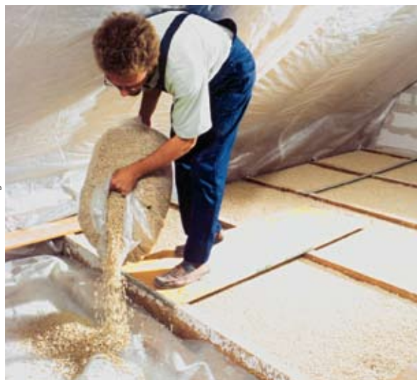
Abb. 7: Schüttdämmstoff Ceralith® als Wärmedämmstoff und Ausgleichsschüttung
